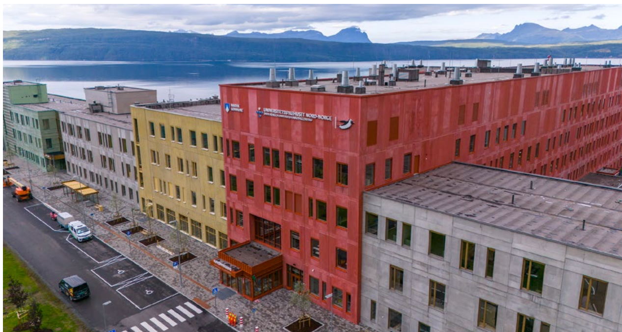
Universitetssykehuset i Nord-Norge HF. Foto: Universitetssykehuset i Nord-Norge HF/Andreas Sletti
