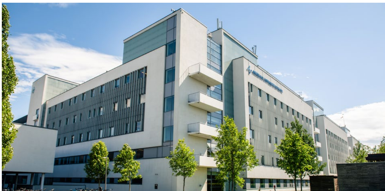
Akershus universitetssykehus HF. Foto: Akershus universitetssykehus HF
